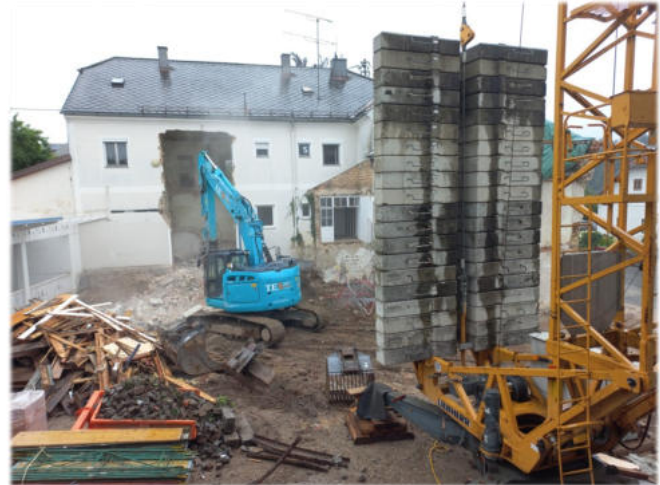
Foto SPÖ-Dimbach: Baustelle beim neuen Marktzentrum
